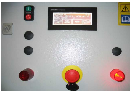
SPS Steuerung mit Touchscreen
